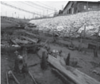
▲大型の板材を利用した護岸施設
