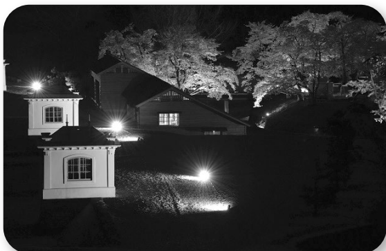
(撮影地:旧美歎水源地水道施設)
