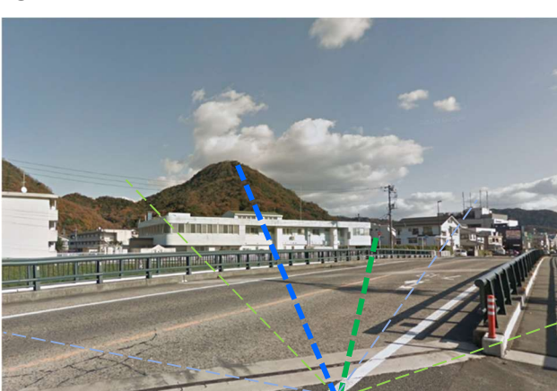
⑥ 国道53号線（湯所橋西橋詰）
