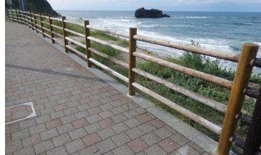
【木製ガードレール】
