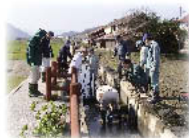
用水路清掃作業
