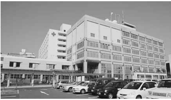
建築後46年が経過した市役所本庁舎
