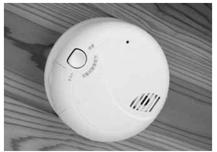
設置された家庭用火災警報器
