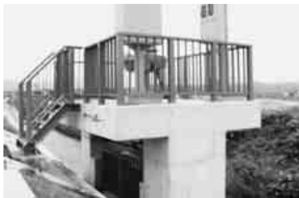
さらなる防災体制の強化が求められる大路川樋門
