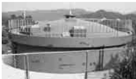
河原地域に水を供給する配水池(散岐配水池)
