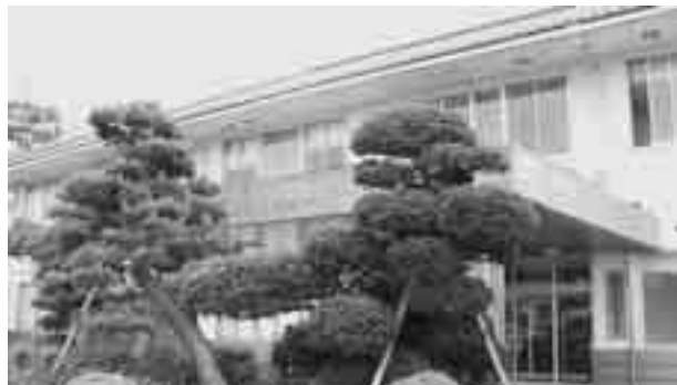
使用終了後の活用が検討される殿ダム工事事務所
