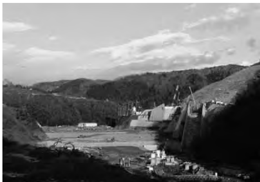
工事が急ピッチで進む殿ダム
