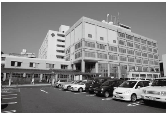
新築、耐震改修等、今後のあり方が問われる市庁舎
