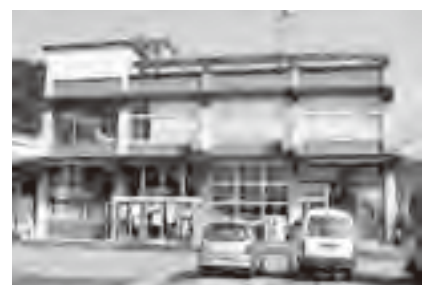
あり方が問われている総合支所
