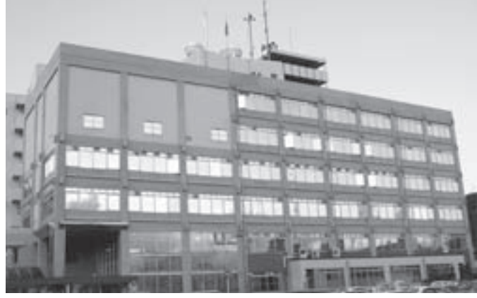
一元管理システムの導入が提案された市有建造物
