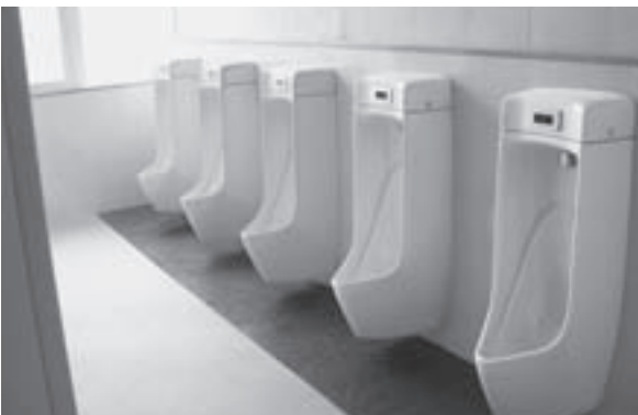
新しく整備された小学校のトイレ
