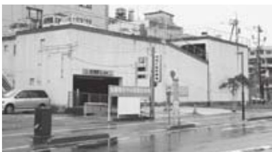
建設反対期成同盟会より変電所の代替地として提供を求められた市営片原駐車場
