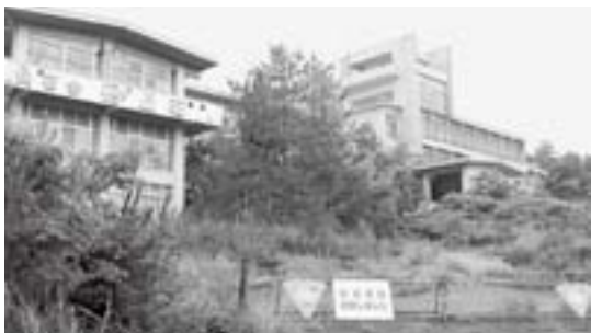
ホテルが建設される予定の旧砂丘荘跡地
