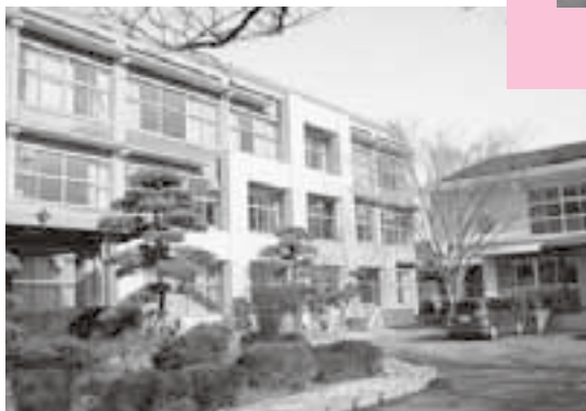
耐震工事が完了した鹿野中学校
