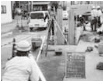
整備が進められている公共下水道
