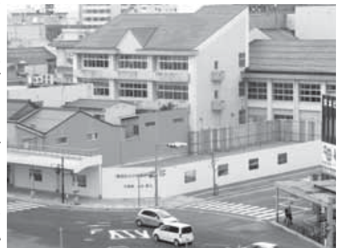
昨年12月に工事着手された、中国電力旧鳥取支店跡地
