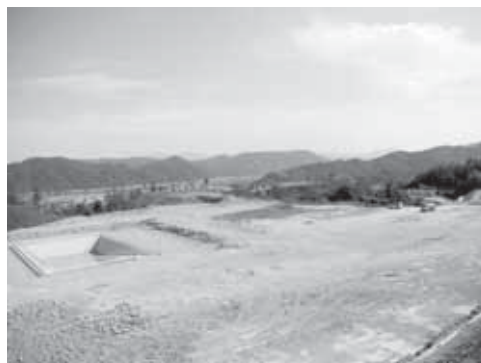
整備が進められている浄水場
