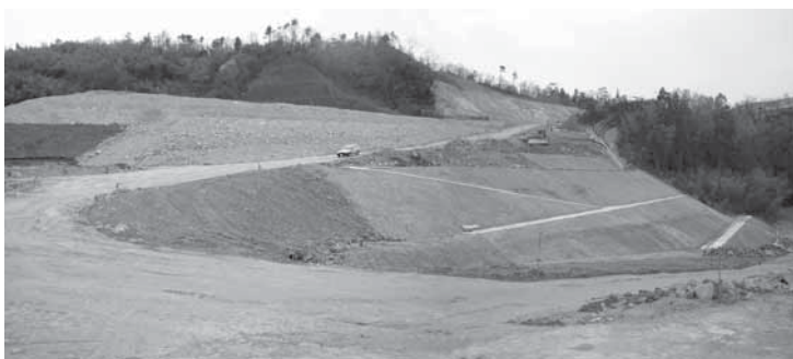
江山浄水場建設の現場
