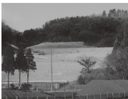
工事を中止している江山浄水場
