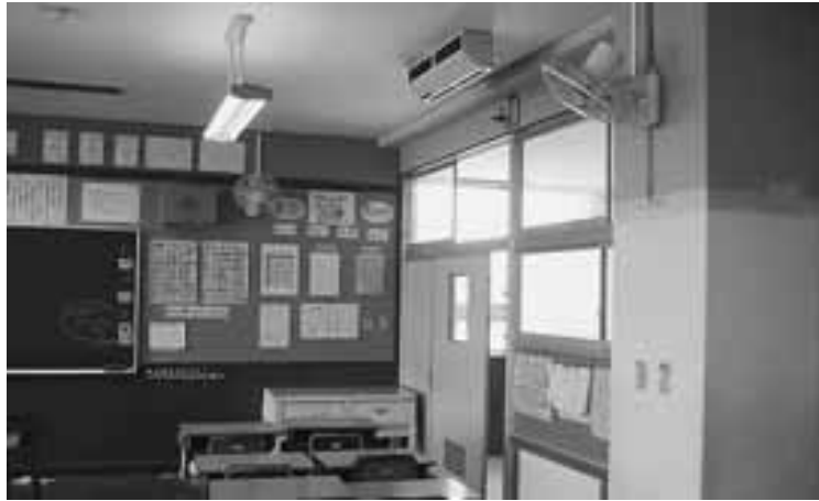
年次的に整備が進められている学校の扇風機(壁上部)
