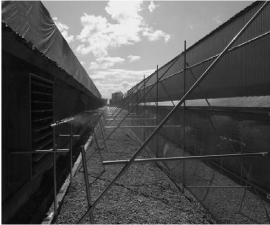
大規模養鶏場に設置された消臭装置
