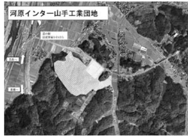
河原インター山手工業団地予定地 (中央斜線部)
