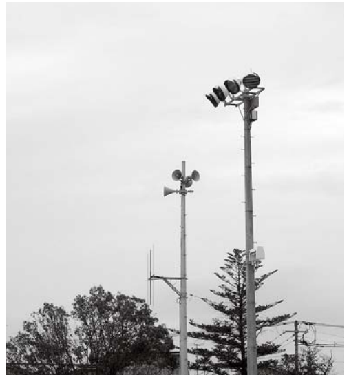
平成22年度に整備が完了した鳥取国府地域の防災無線
