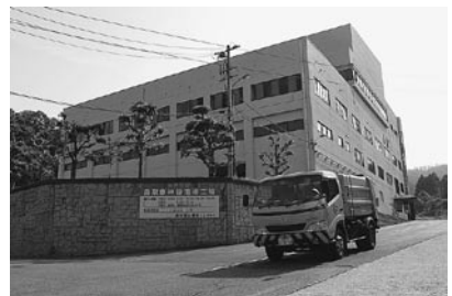
現在稼働中の「神谷清掃工場」
