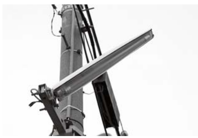
LED化された防犯灯
