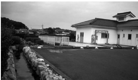
集落排水施設 (写真は松保処理場)
