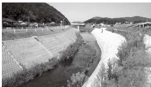
改良が進められている大
