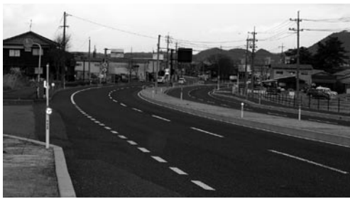
4車線化された叶周辺の国道53号線
