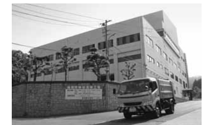
現在稼働中の可燃物処理施設 (神谷清掃工場)
