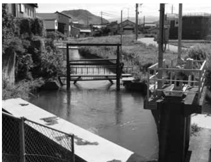
大路川周辺で治水対策事業が進められている
