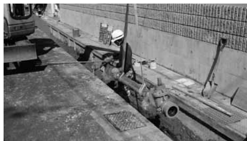
老朽化した水道管が計画的に更新されている
