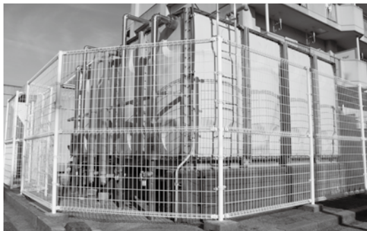
市営住宅に設置されている貯水槽
