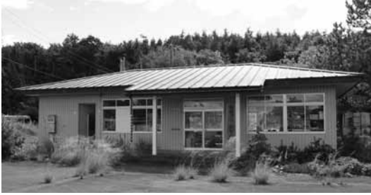
再開に向けた検討が進む鳥取クレー射撃場
