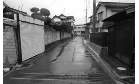
拡幅された市道
