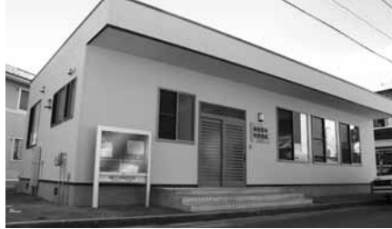
補助制度を活用して整備された桜谷団地町内会館
