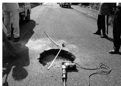
陥没した市道
