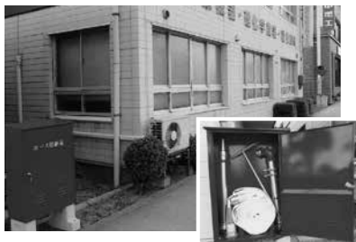
消火用具が入っているホース格納箱
