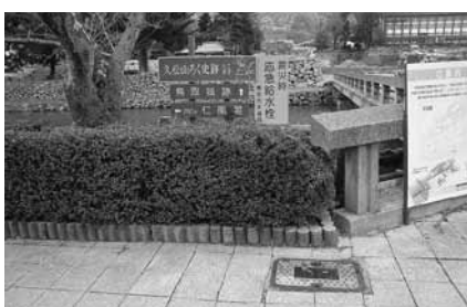
震災時応急給水栓
