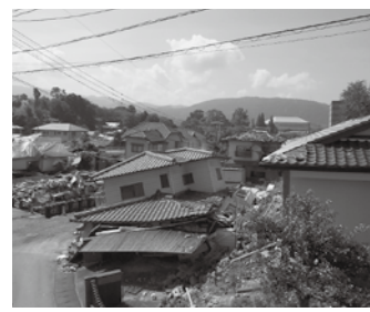
地震で被害のあった熊本県益城町
