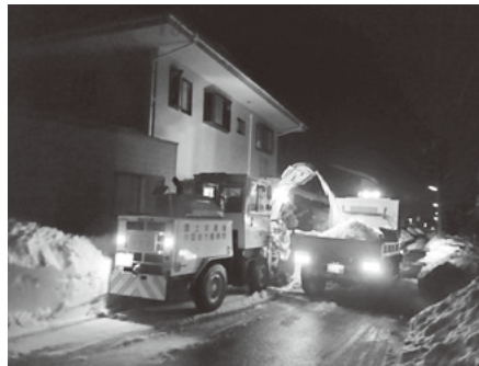
豪雪により昼夜を問わず行われた除雪作業
