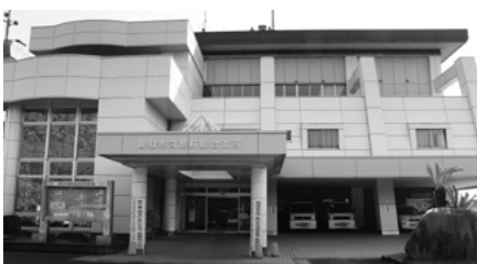
今後、耐震化が進められる総合支所（写真は河原町総合支所）
