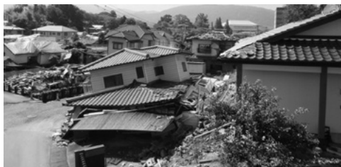
平成28年4月の熊本地震で倒壊した住宅 (熊本県益城町)
