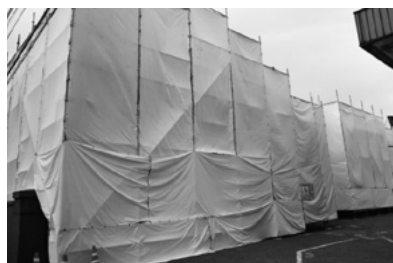
石綿飛散防止のため養生した建物
