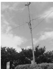
デジタル屋外拡声子局（写真は青谷町の整備例）
