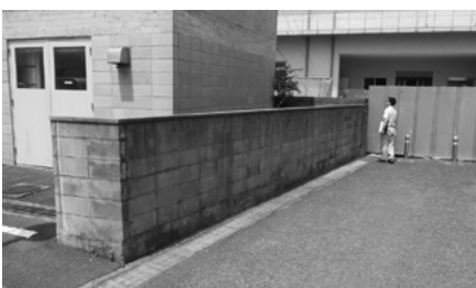
市役所本庁舎ブロック塀（撤去済み）
