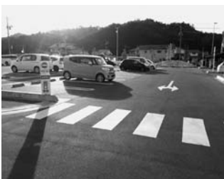
西いなば気楽里駐車場の様子
