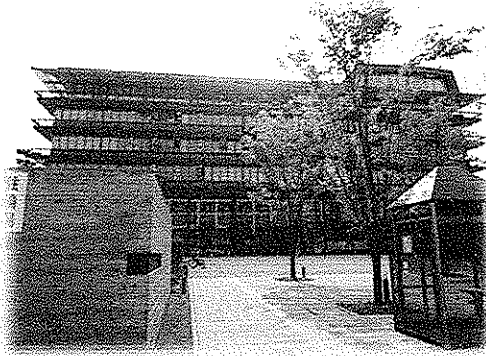
出雲市庁舎外観
