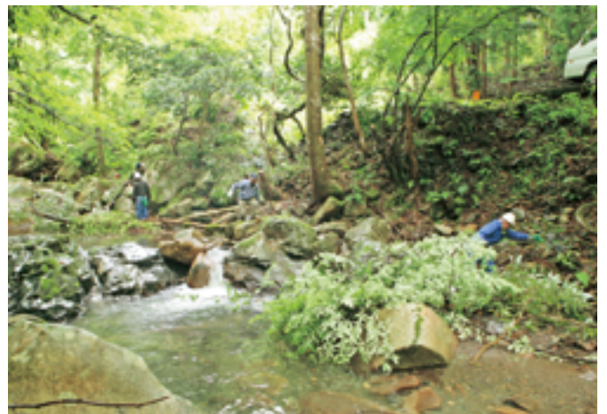
おう穴群の見通しをよくするために木の伐採を実施
