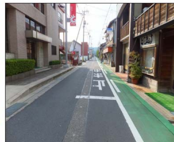
②県道八束水勝見線(勝見地内)
