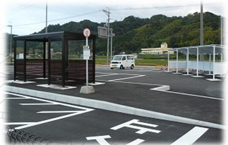
新設された乗継拠点
