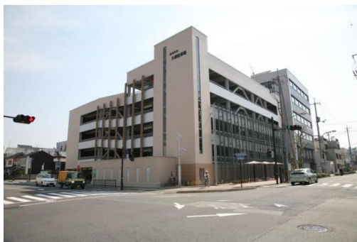
市営片原駐車場改築 【平成22年度完了】
