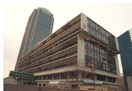
阪神・淡路大震災で6階部分が崩壊した 神戸市役所2号館（前の建物）
