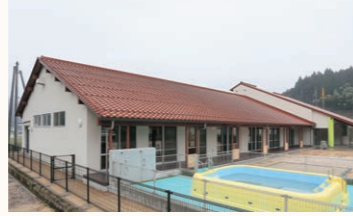
さじ保育園新設
