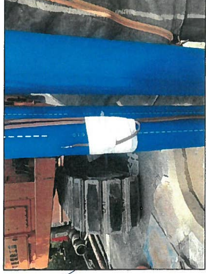
地中熱交換器設置工 温度センサー設置状況
