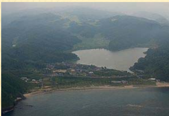
気高町水尻池
