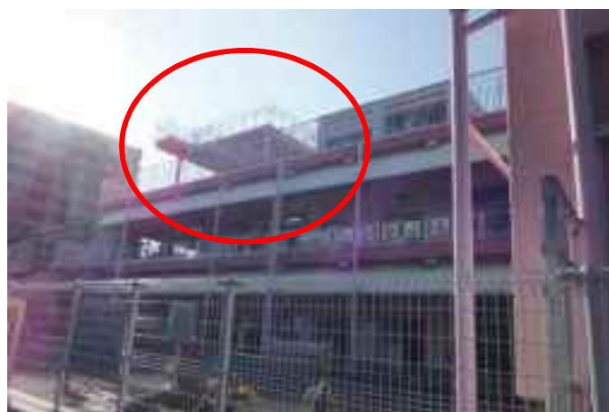
図 15 屋上への避難場所を増築した事例
