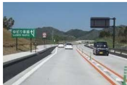
写真6: 山陰近畿自動車道
