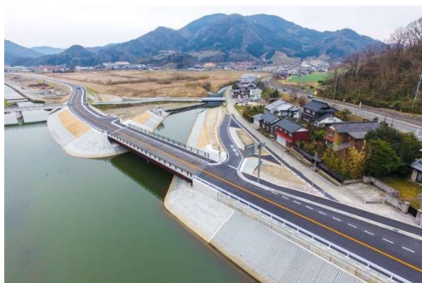
写真3: 箭溪川（江川）との合流部の改修状況
