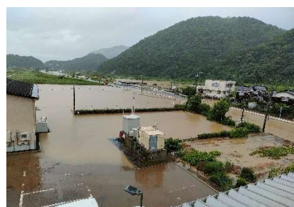
写真28: 塩見川水害状況
