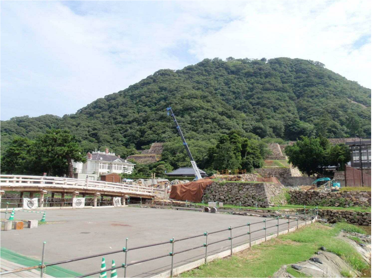
撤去する仮設ヤード
