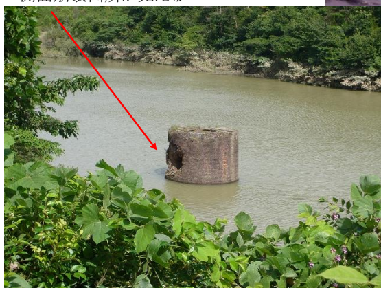
外壁(湛水時) 側面崩壊箇所が見える
