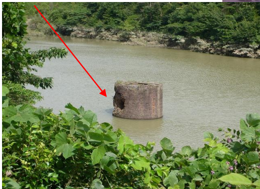
外壁(湛水時) 側面崩壊箇所が見える
