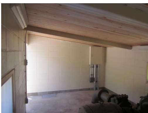
右奥に分電盤 (倉庫兼受付棟内)
