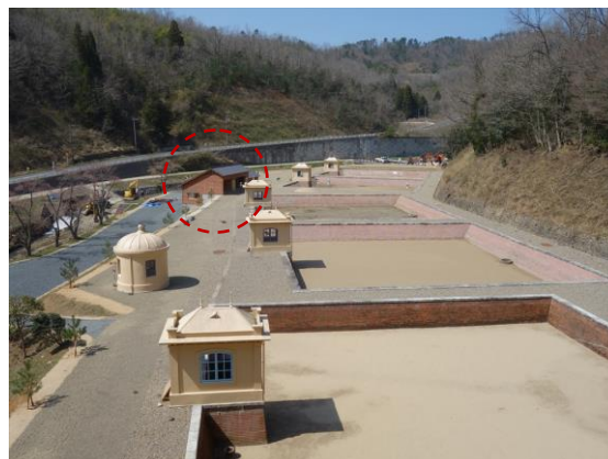
濾過池全景(平成30年)
