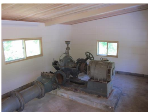
屋内ポンプ機器（残置）
