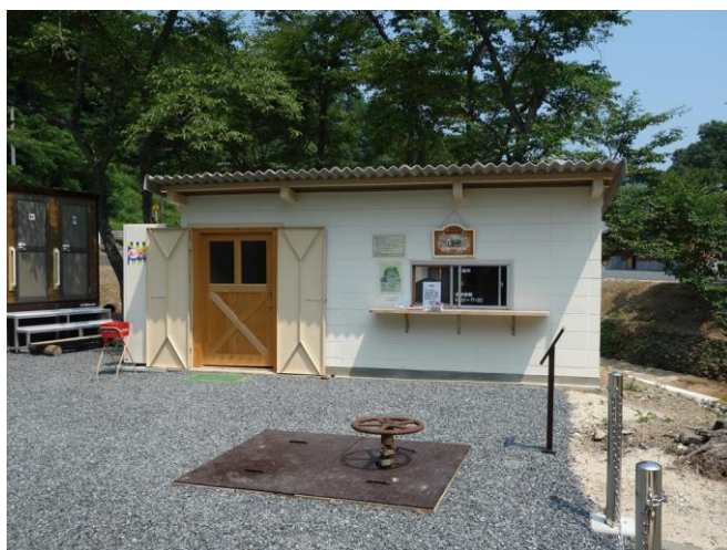
完成写真（南側外観）
