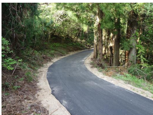
見学路(右岸)アスファルト舗装
