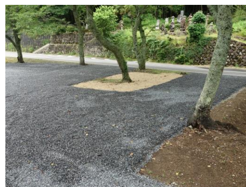
樹脂製枠近景(砂利充填)
