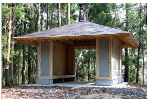
完成写真(南側外観)
