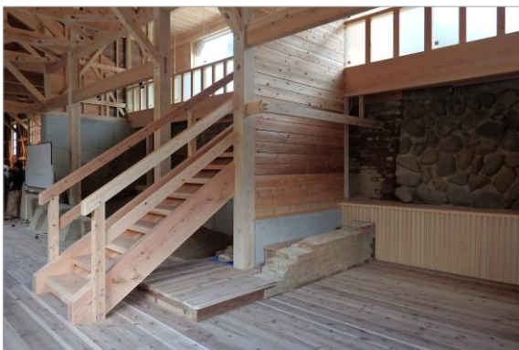
完成写真（屋内南側2F昇降部）
