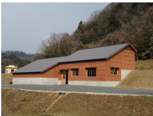
完成写真（西側外観）
