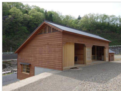
完成写真（南側外観）
