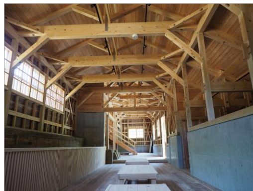
完成写真（屋内南側方向）
