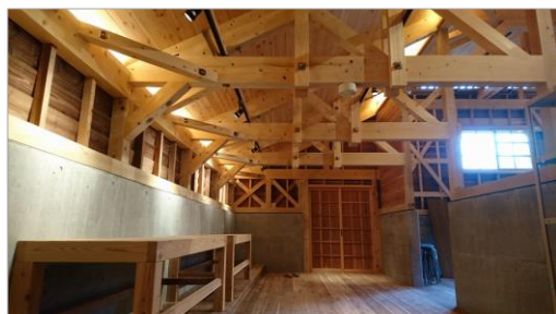
完成写真（屋内北西側）
