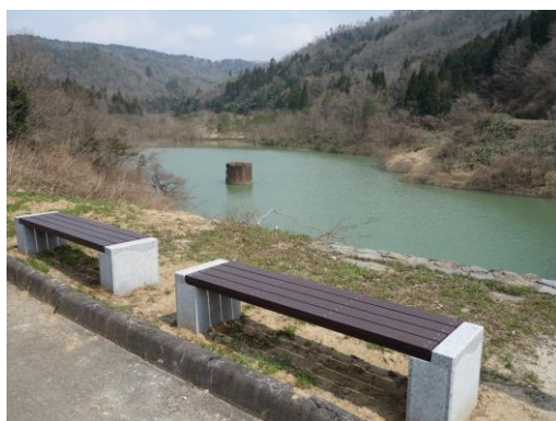
眺望ゾーン(堤体右岸側)
