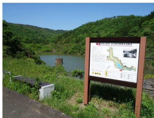
眺望ゾーン(堤体右岸側)
