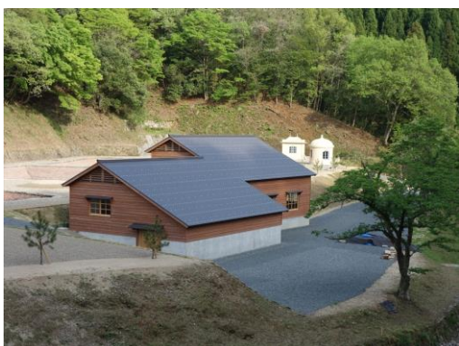
完成写真（北側外観）
