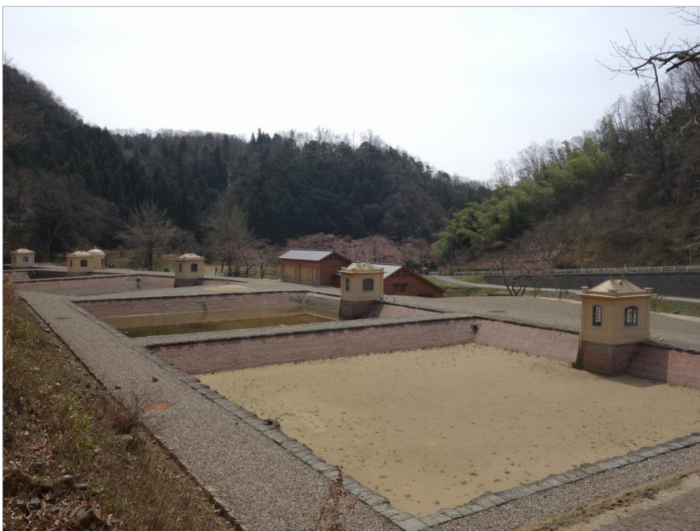
展示・学習ゾーン全景（一号濾過池東側より）
