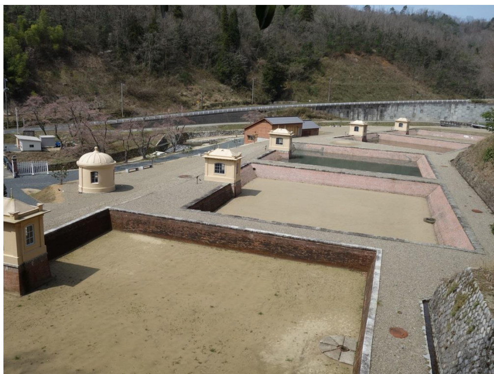
展示・学習ゾーン全景（五号濾過池南側より）
