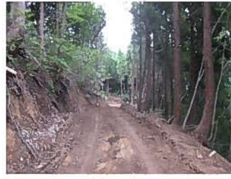
(作設後の作業道)
