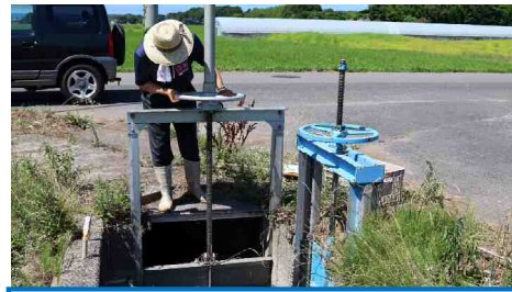
水番によるきめ細やかな配水管理
