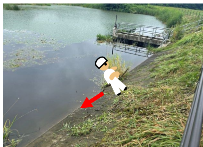
(ため池堤体の急傾斜)
