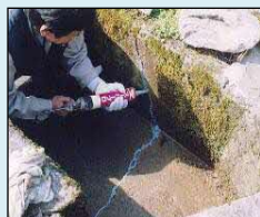
ひび割れの補修
