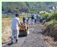
未舗装農道の舗装
