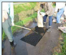
農道の部分補修
