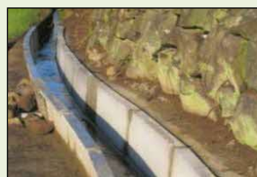
素堀り水路からの更新
