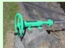
ゲート、バルブの更新
