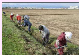
水路の泥上げ
