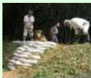
漏水箇所の補修
