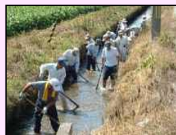
水路の泥上げ
