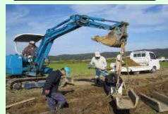
コンクリート水路の更新
