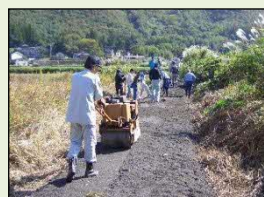
未舗装農道の舗装
