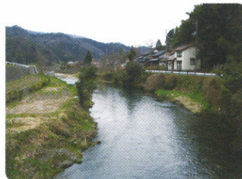
つく谷橋より下流を望む
