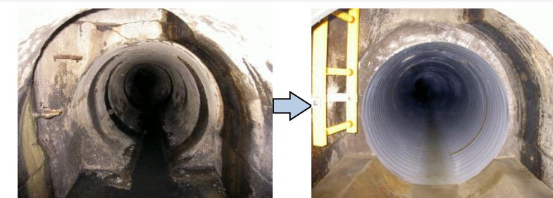
着工前 地震対策下水道事業による管渠改築 完成
