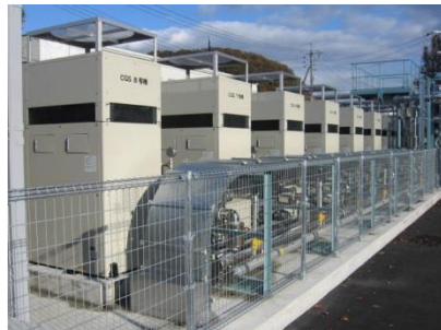
完成した発電設備
